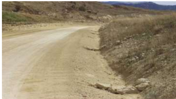
Fotografía N° 10: Drenaje de camino
