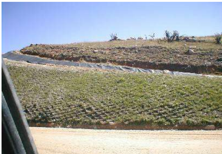
Fotografía N° 2: Restauración de talud en etapa inicial con geoceldas,
