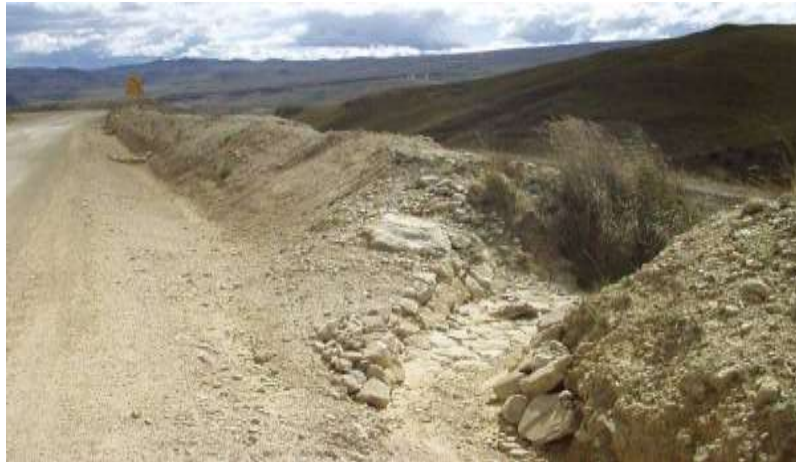
Fotografía N° 12: Abertura de berma
