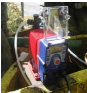
Fotografía N° 14: Bomba dosificadora
