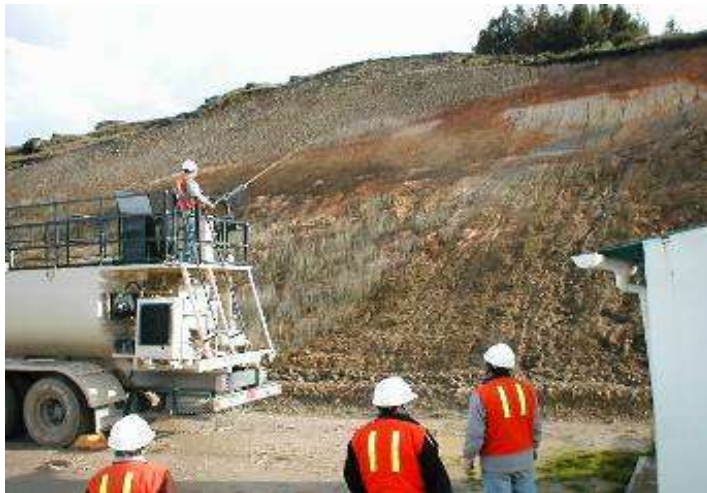
Fotografía N° 5: Hidrosembrado (hidráulico) de un tajo del camino
