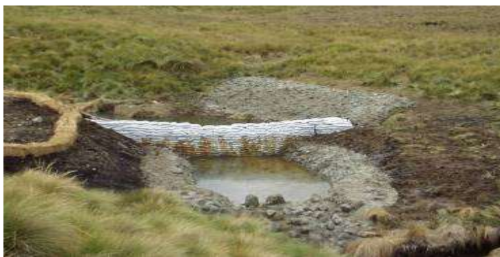
Fotografía N° 7: Estructuras de sacos con concreto
