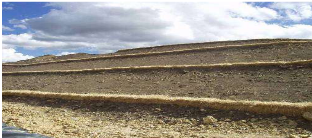
Fotografía N° 8: Aplicación de pacas de paja
