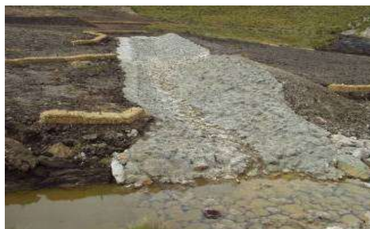
Fotografía N° 1: Canal con rip-rap con lechada de concreto.
