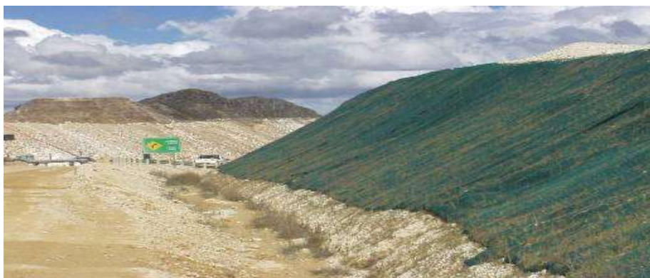
Fotografía N° 6: Mantas para el control de la erosión
