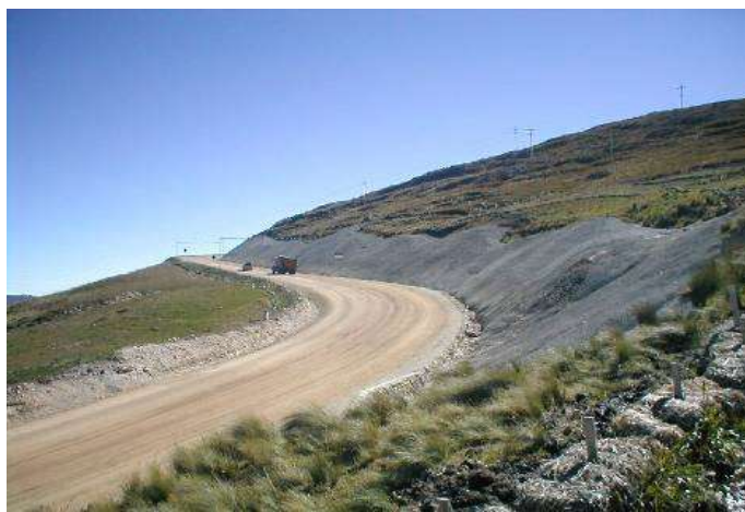
Fotografía N° 3: Talud de corte con PGA encapsulado usando
